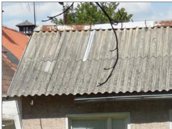
Fot.1 Płyty azbestowo-cementowe faliste
