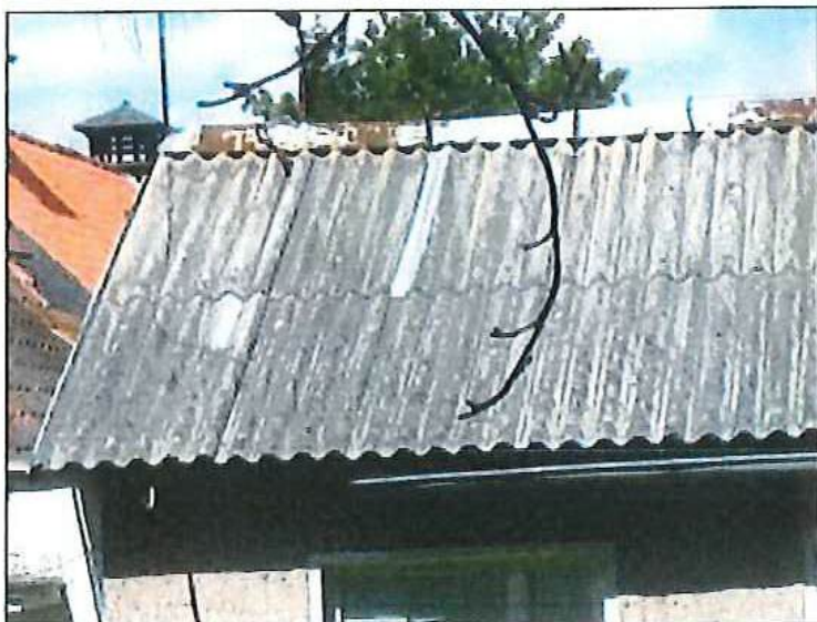
Fot. 1 Płyty azbestowo-cementowe faliste
