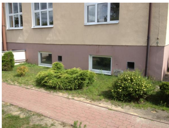
Otwory okienne i kratki nawiewne.
