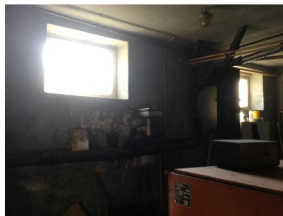
Istniejące otwory okienne, od wewnątrz kotłowni.
