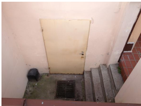
Wejście do kotłowni.
