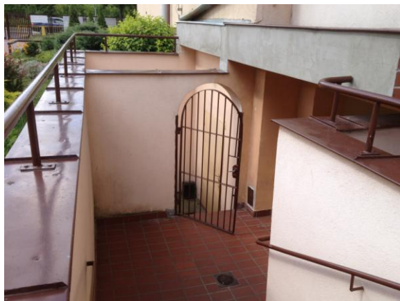
Zejsście do kotłowni.
