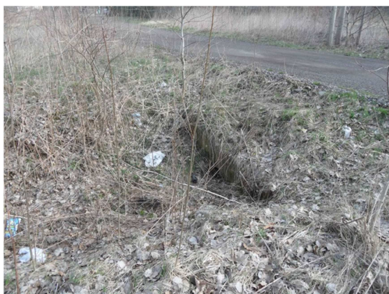
Fot. 3 Istniejący przepust
