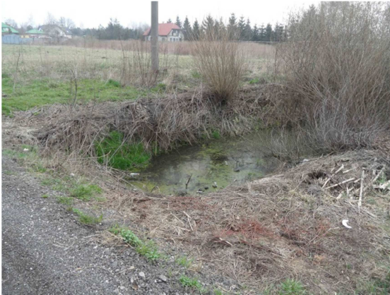
Fot. 7 Kanał Z-1 wraz z istniejącym przepustem
