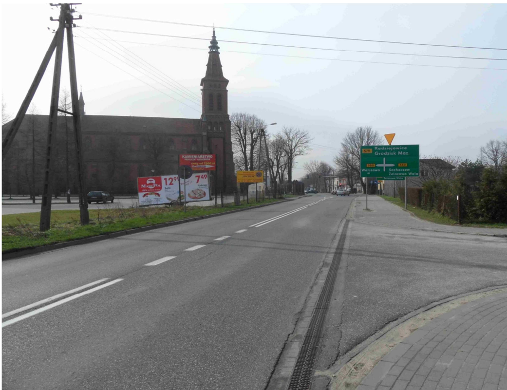
Zdjęcie 1 DW 579 – widok na skrzyżowanie z ul. Jaśminową
